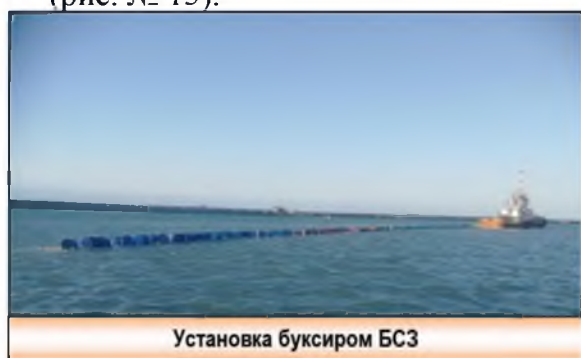
Рис. № 14 Установка буксиров БСЗ
