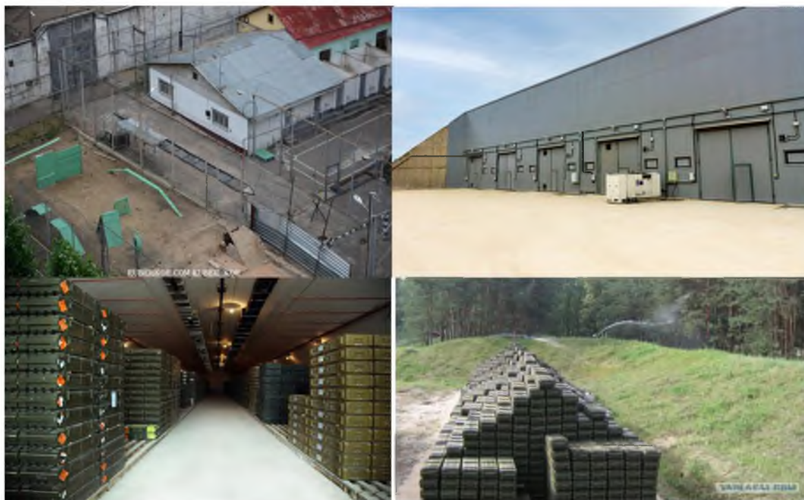
Рисунок 1.3 - Фрагменты зданий и мест хранения боеприпасов на стационарных складах РАВ
