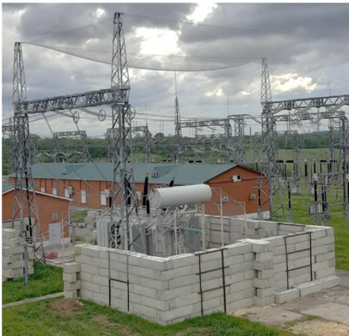
Рисунок IV.4 - Пример реализации комплекса технических решений: горизонтальная защитная сетка и защитное ограждение из блоков ФБС
