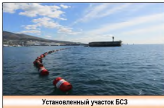
Рис. № 15 Установленный участок БСЗ
