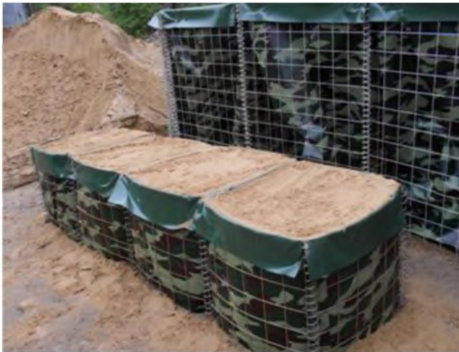
Рисунок V.51 - Грунтонаполненные габионы типа «ГНТ»
