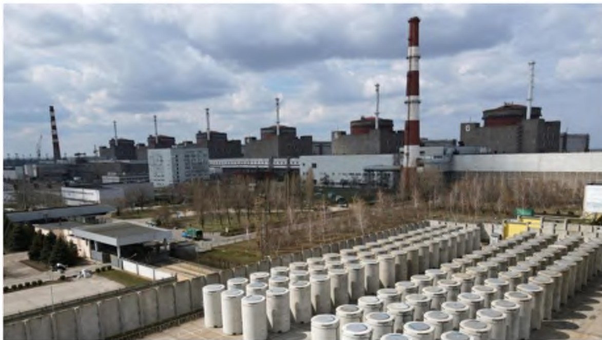
Рисунок IV.38 - Схема открытого расположения контейнеров с радиоактивными отходами на Запорожской АЭС
