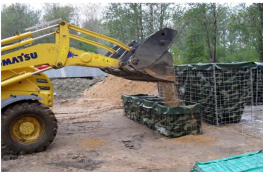
Рисунок V.52 - Процесс наполнения яруса габионов типа «ГНТ»
