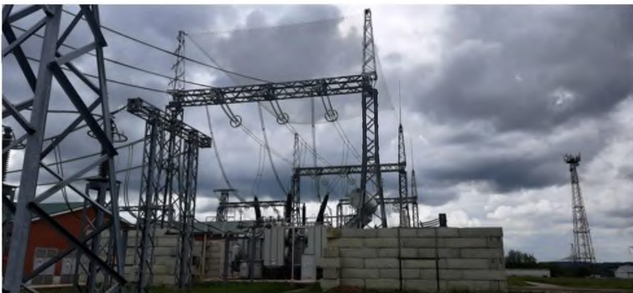
Рисунок IV.3 - Пример реализации комплекса технических решений: горизонтальная защитная сетка и защитное ограждение из блоков ФБС
